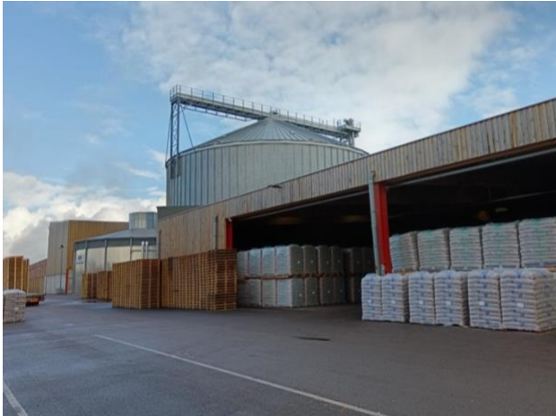
Les bâtiments de stockage et le silo de 7500t
